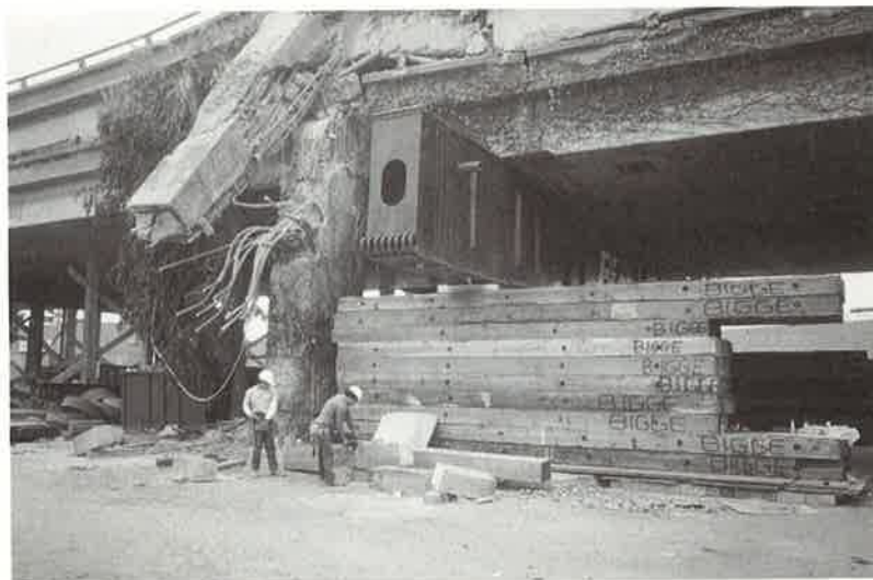
Bild 63, Sicherung der Stahlbetonkonstruktion mit schweren auf Holzbalken aufgelegten Stahlträgern
