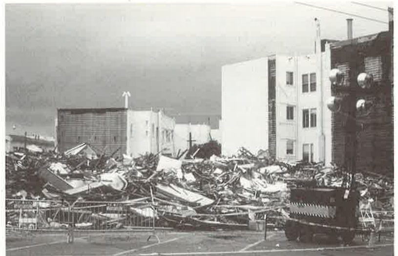
Bild 16, Komplette eingestürztes nur einseitig angebautes Eckhaus (Ecke Cervantes Boulevard - Fillmore Street, Marina Quartier, San Francisco)
