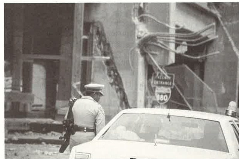
Bild 53, Polizeikontrollen am eingestürzten Interstate Freeway 880 in Oakland
