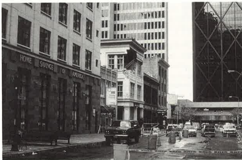
Bild 4, Durch das Erdbeben schwer beschädigtes Mauerwerksgebäude in mitten unbeschädigter Hochhäuser im Finanzviertel von San Francisco
