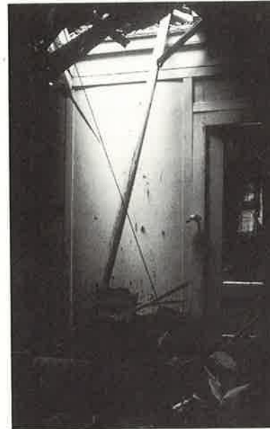
Bild 69 und 70, Erdgeschossräume von gebäuderückseitigen Anbauten, bei denen die Decke (links) oder das Oberlicht (rechts) von Trümmern durchschlagen wurde (Pacific Garden Mall, Santa Cruz)
