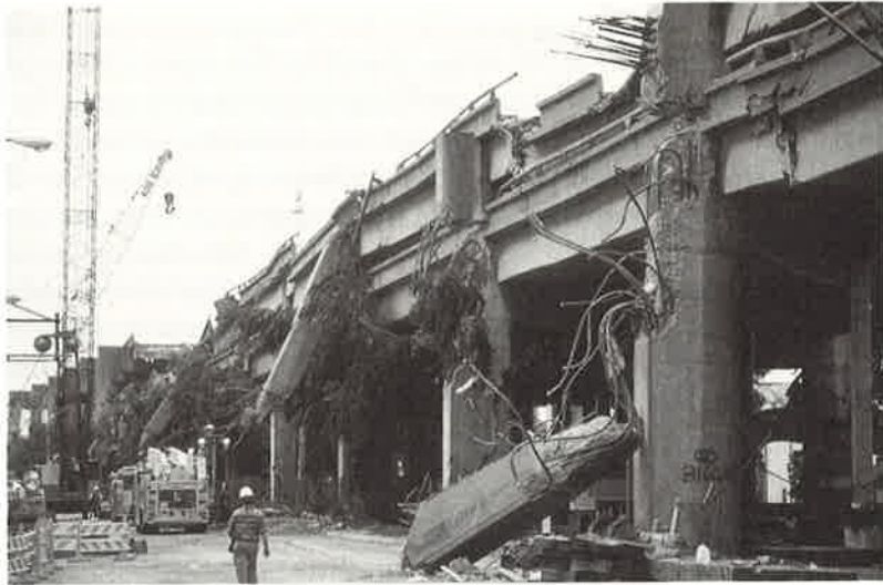
Bild 36, Auf einer Länge von über 1,5 Kilometer eingestürzte Hochstrassenbrücke (Cypress structure) des Interstate Freeways 880 in Oakland
