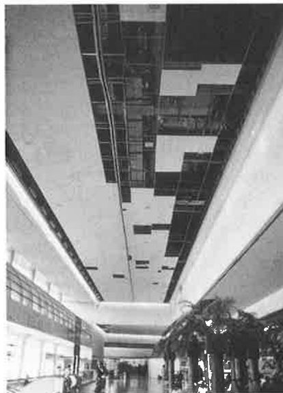
Bild 28 und 29, Schäden an den nicht zum Tragwerk gehörenden Einbauten in der Eingangshalle des Internationalen Flughafens von San Francisco (links) und am AT&T Gebäude in Oakland (rechts)
