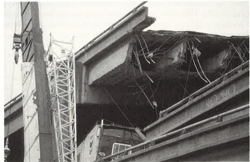
Bild 39, Die zweistöckige Hochstrassenbrücke hielt dem Beben nur auf einem kurzen 25 Meter langen Autobahnabschnitt stand
