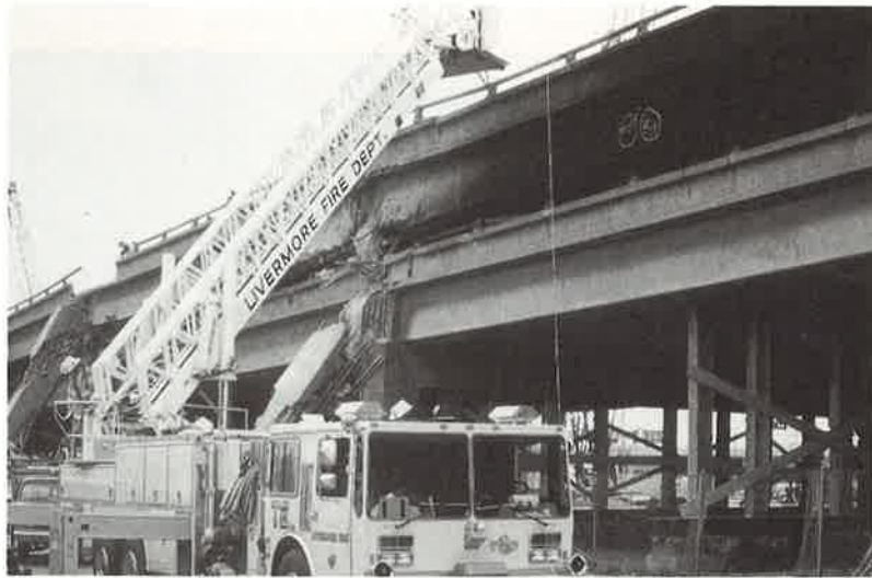
Bild 56, Drehleiter der Feuerwehr für den Zugang zu den hochgelegenen Trümmern. Man erkennt auch den durch die Fahrzeugbrände nach dem Beben geschwärzte Brückenrand. Die Brücke ist durch ein Holzfachwerk gesichert
