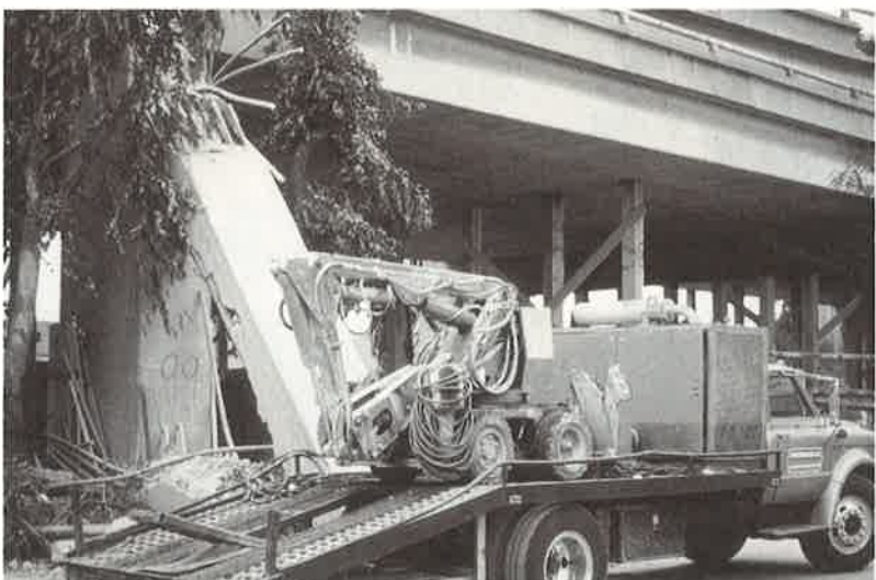
Bild 61, Hydraulischer Abbauhammer auf leichtem Fahrwerk mit einer externen auf einem Lastwagen aufgebauten Oeldruckanlage
