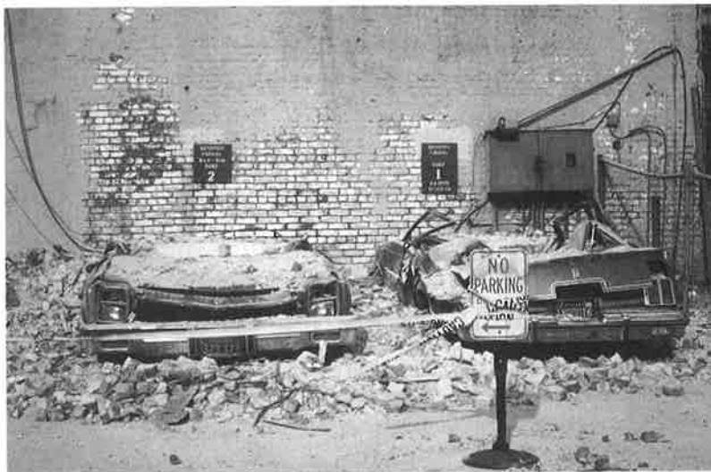
Bild 23, Durch die abstürzenden Mauerwerkstrümmer zerstörte Fahrzeuge
