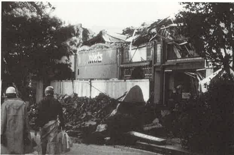
Bild 75, Die meisten Bauten an der Pacific Garden Mall in Santa Cruz wiesen schwere Erdbebenschäden auf - einige Gebäude stürzten vollständig ein
