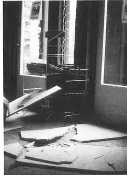
Bild 26 und 27, Erdbebenschäden am Verputz und an abgehängten Decken in Bauten an der Pacific Garden Mall in Santa Cruz
