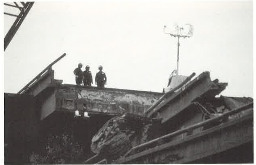
Bild 58, Zahllose Beleuchtungsanhänger mit Teleskopmasten ermöglichten, dass die Rettungsarbeiten im Schichtbetrieb auch in der Nacht weitergeführt werden konnten
