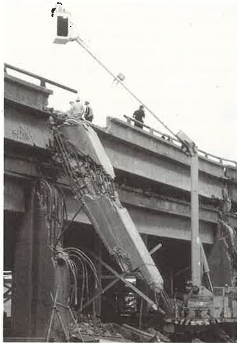
Bild 56, Drehleiter der Feuerwehr für den Zugang zu den hochgelegenen Trümmern. Man erkennt auch den durch die Fahrzeugbrände nach dem Beben geschwärzte Brückenrand. Die Brücke ist durch ein Holzfachwerk gesichert
