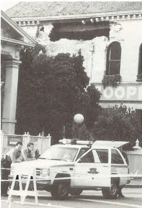
Bild 20, Unterhalb der Dachtraufe abgestürzte Mauerwerkspartie. Das abgebildete Cooper Building wurde eine Woche nach dem Erdbeben abgerissen (Pacific Garden Mall, Santa Cruz)
