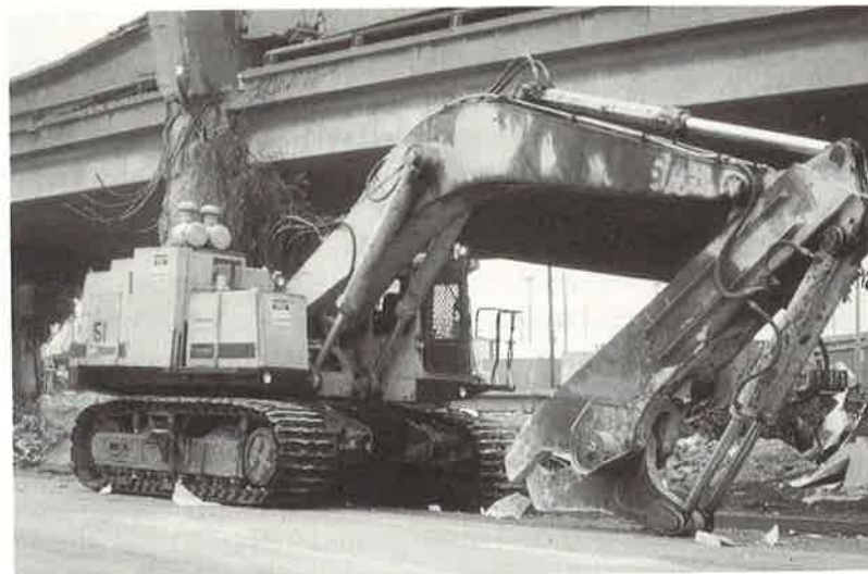
Bild 62, Schweres Abbruchgerät vor den Trümmern der Cypress Hochstrasse
