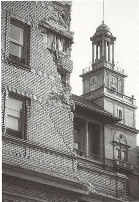
Bild 5, Hotel Oakland, ein aus der Jahrhundertwende stammender als Altersheim genutzter Backsteinbau
