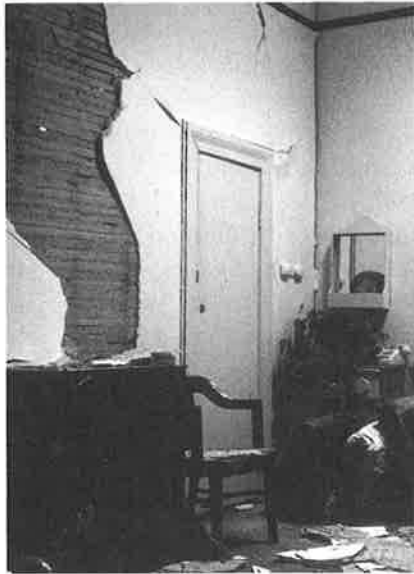
Bild 26 und 27, Erdbebenschäden am Verputz und an abgehängten Decken in Bauten an der Pacific Garden Mall in Santa Cruz
