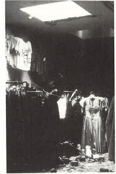
Bild 69 und 70, Erdgeschossräume von gebäuderückseitigen Anbauten, bei denen die Decke (links) oder das Oberlicht (rechts) von Trümmern durchschlagen wurde (Pacific Garden Mall, Santa Cruz)
