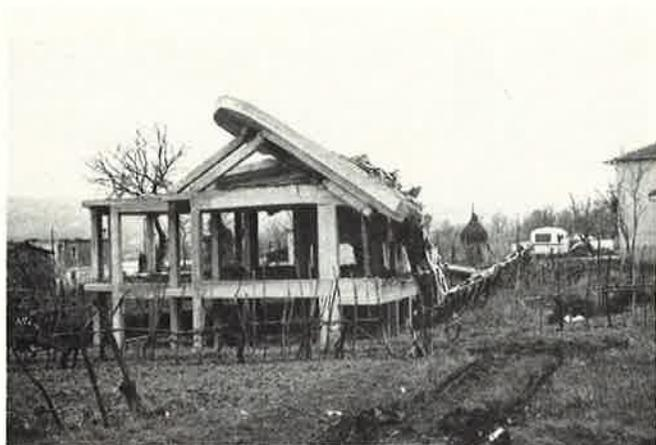
Lioni, "La Rotonda", im Bau befindlicher Stahlbetonskelettbau
