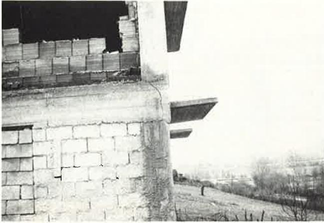
Lioni, Typischer Schaden an wenig beschädigten Stahlbetonskelettbauten, Risse in den Rahmenecken
