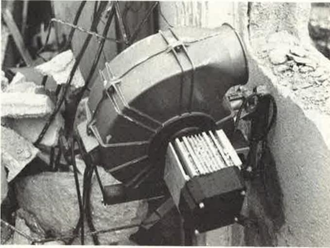
Lioni, Ventilator mit unbeschädigter Befestigung im zerstörten Stahlbetonskelettbau "La Precisa"
