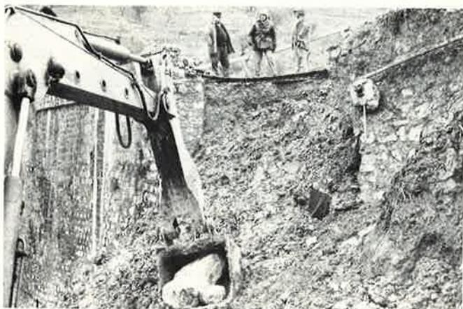
Brücke bei Caposele, Instandstellungsarbeiten an der abgerutschten Widerlagermauer
