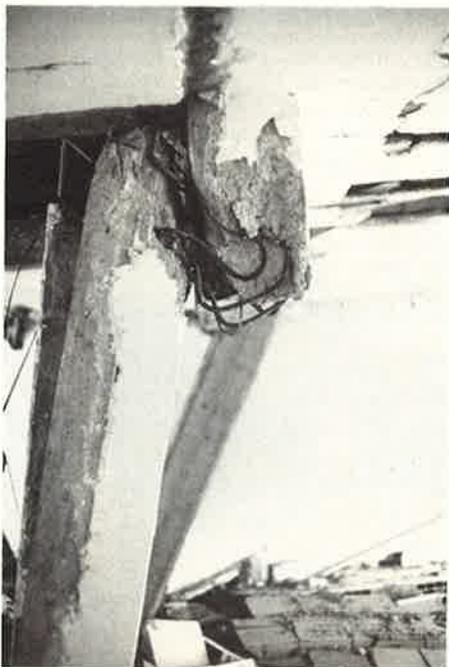
Lioni, Detailaufnahme von "I tre palazzi", Bruch der Stahlbetonstütze unterhalb der Rahmenecke
