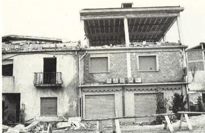
Lioni, "Bar", Beim Gebäude links Dachstock eingestürzt, rechtes Gebäude Füllwände im obersten Stockwerk ausgebrochen und Stahlbetonskelett stark deformiert
