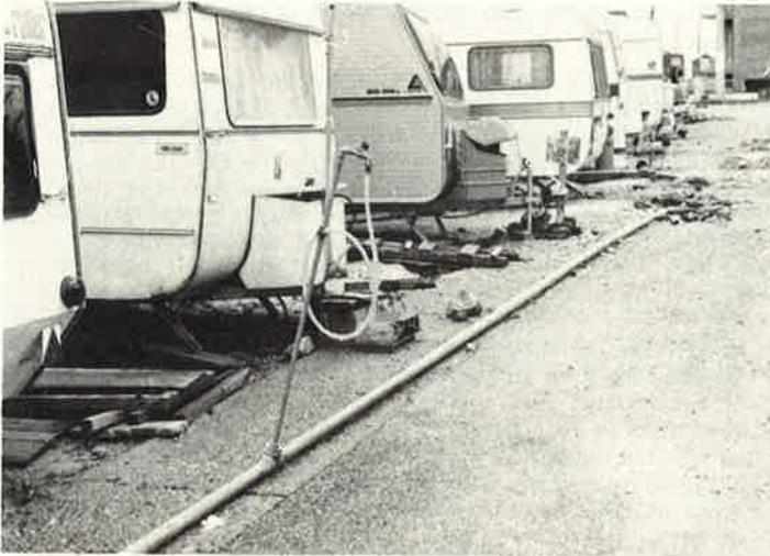
Lioni, Oberirdisches Notwasserversorgungsnetz mit einem Uebergang auf die vergrabene Ausführung
