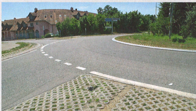
Kleinandelfingen: Die weitgehend bepflanzte Insel ist am Rand mit Rasengittersteinen ausgeführt.
