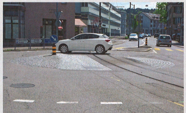
Frauenfeld: Der Kreisel hat einen kleinen Aussendurchmesser. Er ist mit der Pflasterung und der Querung durch ein Bahntrasse gut in die Umgebung eingepasst.
