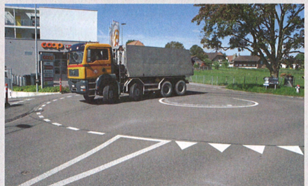
Jegenstorf: Markierte Mittelinseln werden häufig von Lastwagen überfahren.
