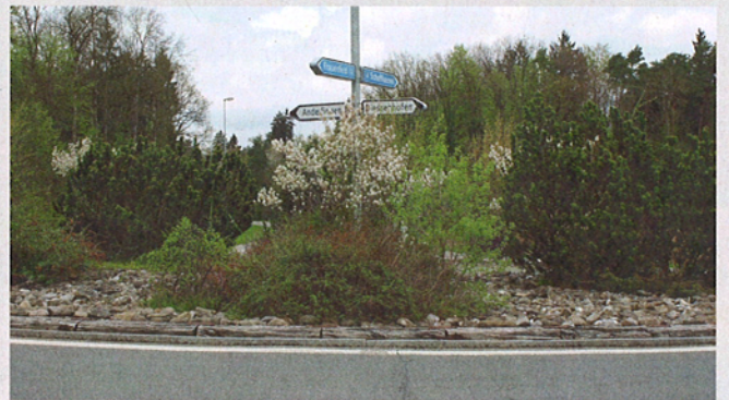
Basadingen: Die Mittelinsel ist mit Steinen und Holzschwellen gestaltet. Der Durchblick auf den Gegenverkehr ist stark erschwert. Die Ausführung kann als Muster für weitere Kreisel empfohlen werden.
