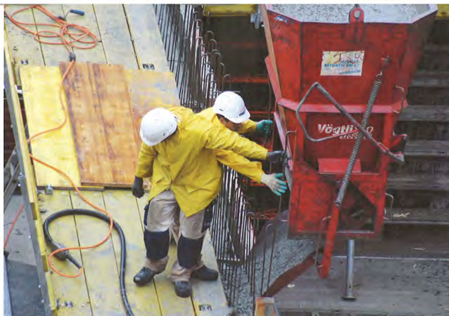
Das A und O beim Betonieren ist eine gute Verteilung des Betons.
