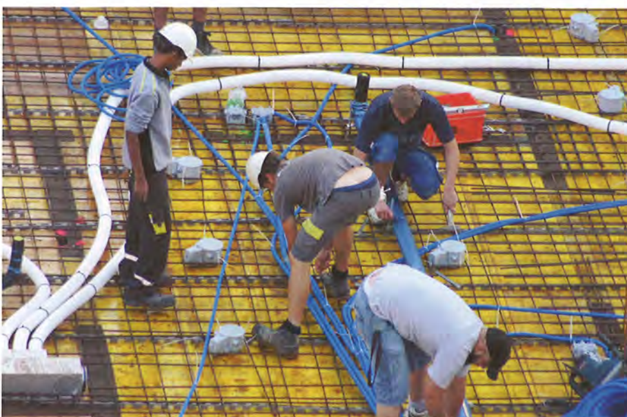
Beim Verlegen der Kabel und Rohre ist präzises Arbeiten entscheidend.
