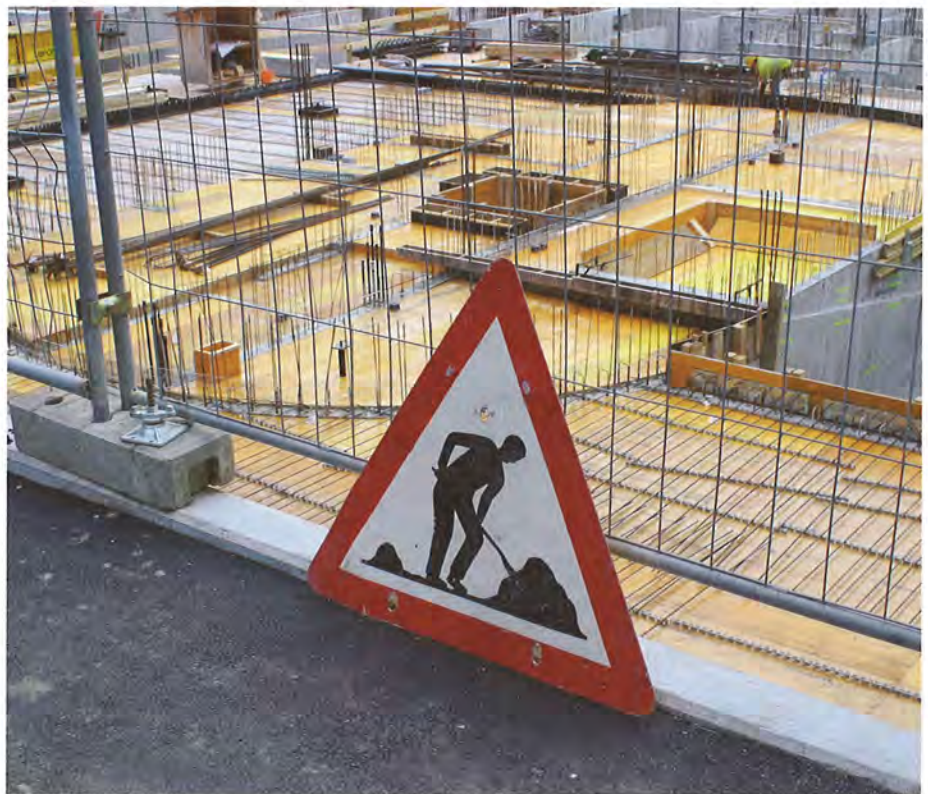
Sobald die Schalung steht, wird die Bewehrung verlegt.
