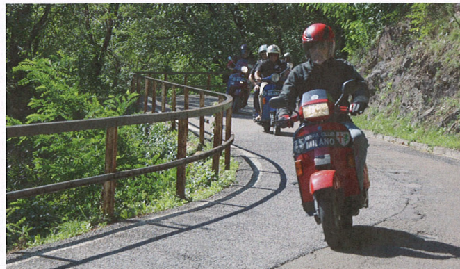
Dieses System besteht aus Stahlprofilen und ist im Tessin verbreitet. Es passt sich (wie hier bei Meride) gut in die Landschaft ein.
