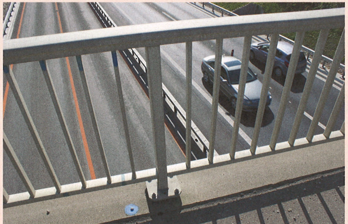
Standardisierte Geländer aus Aluminium finden sich häufig auf Brücken über Schweizer Autobahnen. Bei diesem Beispiel handelt es sich um die Autobahnausfahrt A4 in Trüllikon ZH während einer Instandsetzung der Autobahn.
