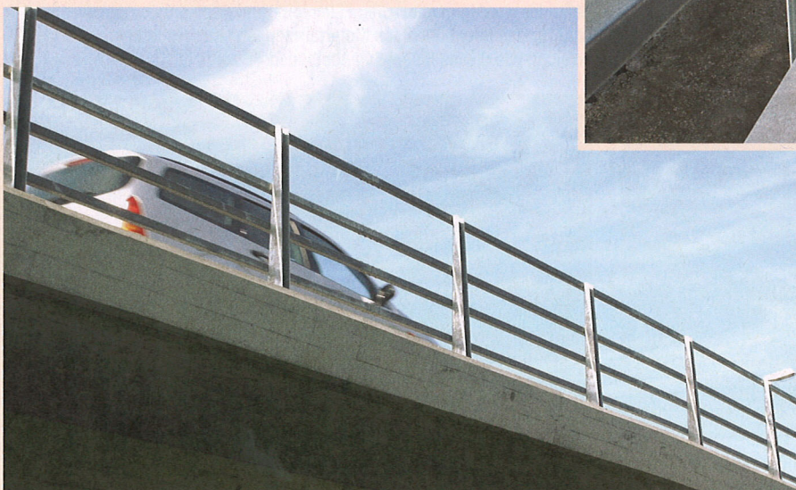
Das in Winterthur installierte System Lenzlinger Metallbau ist eleganter und transparenter als das System LS A-60-40. Es ist ebenfalls wie eine Leitschranke gemäss der Norm SN 1317-2 (Teil 2: Leistungsklassen, Abnahmekriterien für Anprallprüfungen und Prüfverfahren für Schutzeinrichtungen) getestet.
