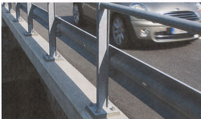
Geländer werden häufig mit Leitschranken ausgerüstet. Eine Wirkung als Fahrzeugrückhaltesystem ist sehr unterschiedlich. Dieses Beispiel stammt aus dem Tessin.
