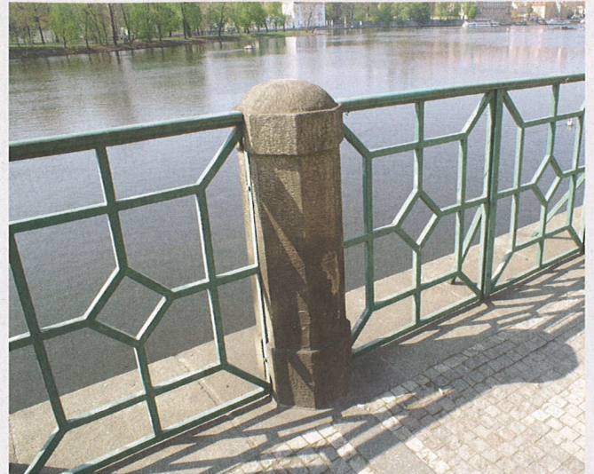
Dieses Geländer an der Moldau in Prag wirkt mit Pfosten aus Natursteinen und einer modernen Füllung aus Stahlstäben attraktiv.
