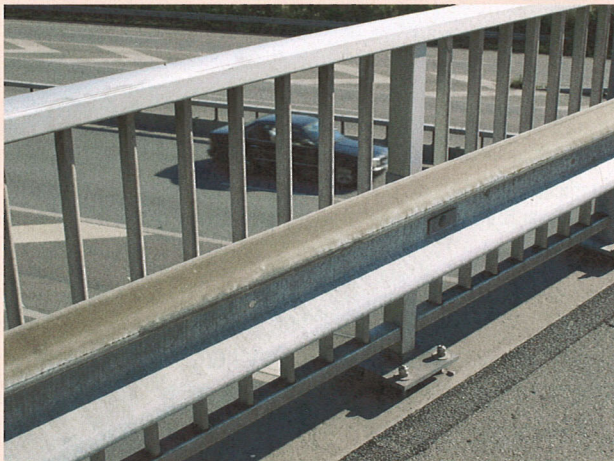
Aluminiumgeländer über Autobahnen (hier A6) sind in speziellen Fällen mit einer Leitplanke ausgerüstet. Damit übernehmen sie weitgehend die Funktion einer Leitschranke. Als System sind sie nicht getestet.
