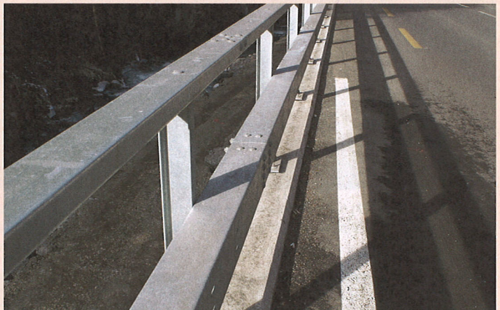
Standardisierte Geländer aus Aluminium finden sich häufig auf Brücken über Schweizer Autobahnen. Bei diesem Beispiel handelt es sich um die Autobahnausfahrt A4 in Trüllikon ZH während einer Instandsetzung der Autobahn.
