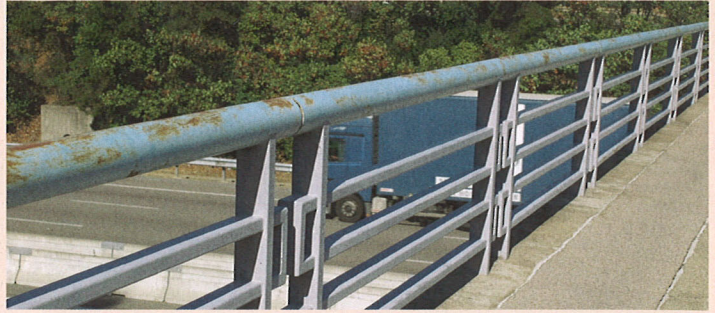
In Frankreich werden Brücken inklusive Geländer von Architekten (bisweilen kunstvoll) gestaltet.
