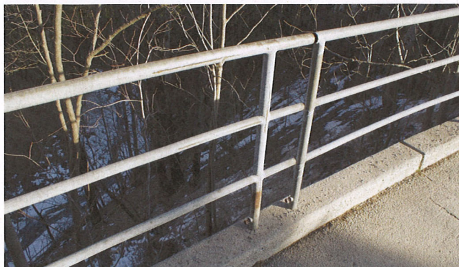
Dieses Geländer, ebenfalls in Adelboden BE, ist der Schweizer «Klassiker». Es besteht aus Stahlrohren und ist schlicht, transparent und schön.
