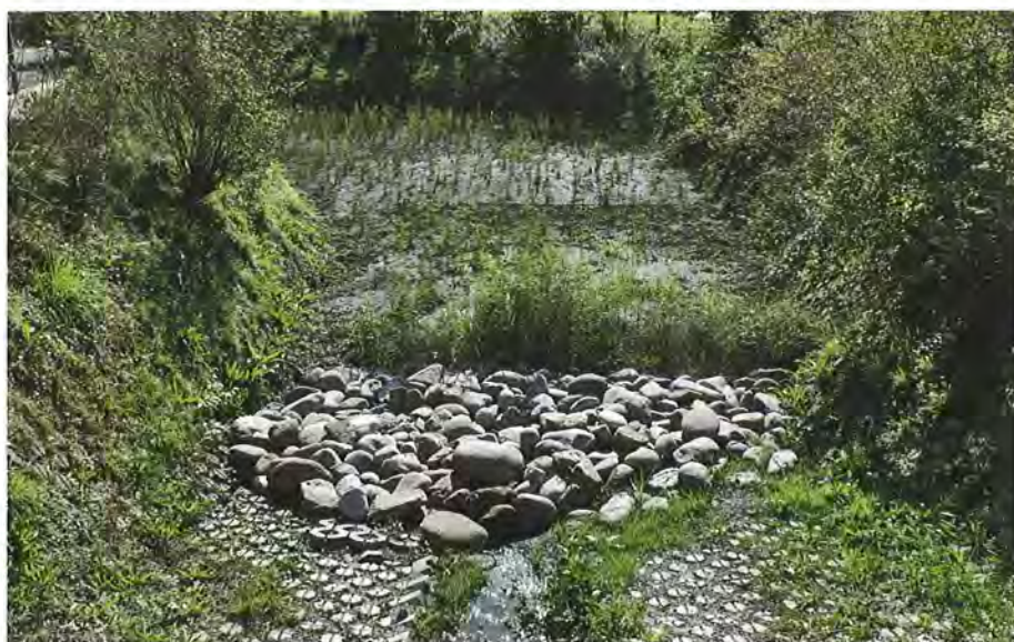
Da die Kosten eines Retentionsfilterbeckens (hier mit Boden und Schilfbewuchs) erheblich sind, sollte die Umsetzung sorgfältig geprüft werden. Bild: zvg
