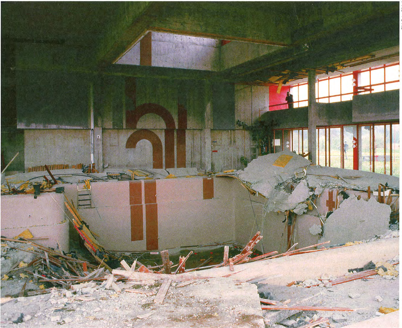
Fatale Konsequenz: Die Wahl eines nicht ausreichend korrosionsbeständigen Stahls führte 1985 zum Einsturz der Decke im Hallenbad Uster.
