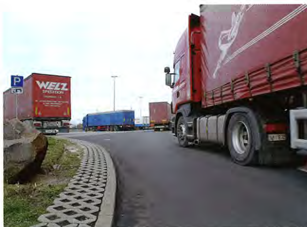
8: Mit Rasengittern verstärktes Bankett.
