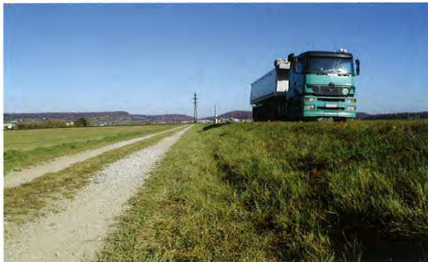
6: Hauptverkehrsstrasse mit Entwässerung über die Böschung.
