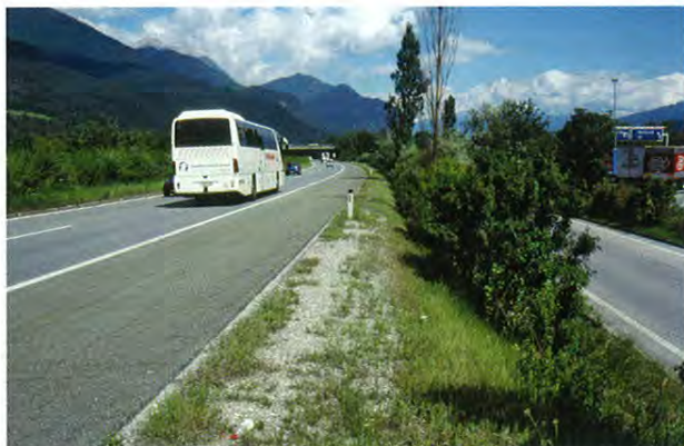
2: Hochleistungsstrasse und Versickerung im Mittelstreifen.
