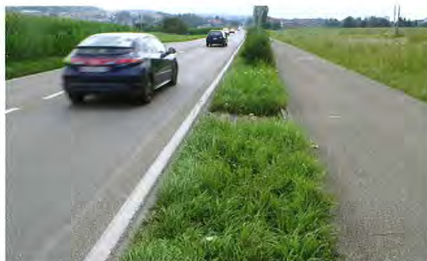
1: Hauptverkehrsstrasse mit Radweg und Versickerung im Trennstreifen.
