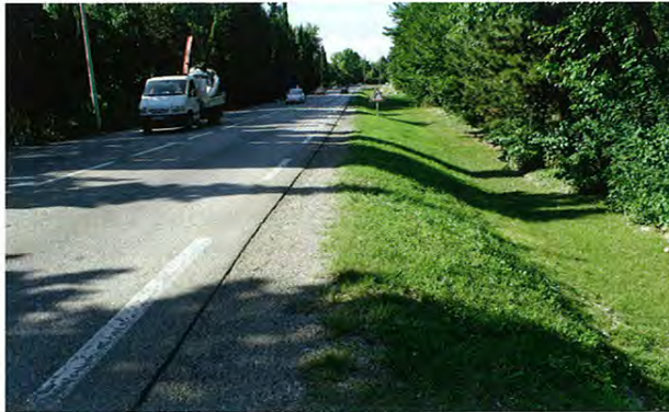
5: Strasse mit Bankett mit toniger Deckschicht.
