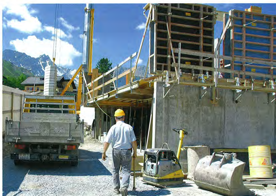
Bau der Parkgarage Innerarosa, Gemeinde Arosa.
