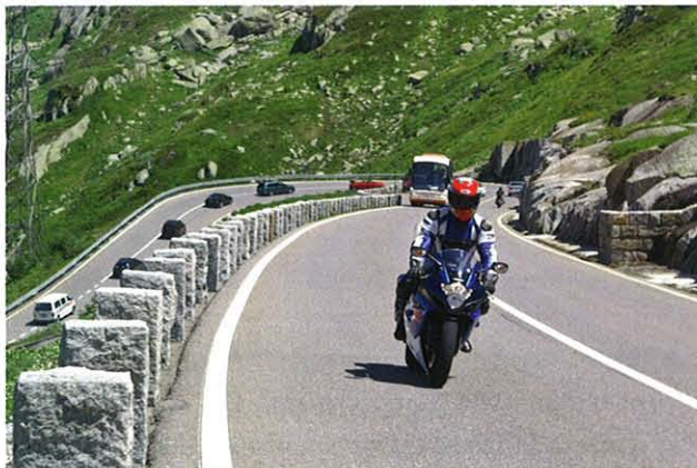
1: Wehrsteine als historische Elemente von Passstrassen.
