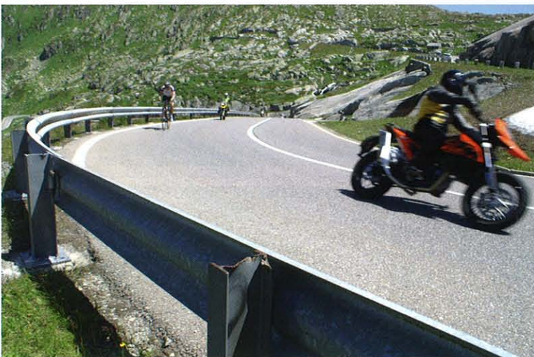
7: Passive Massnahmen wie Unterfahrtschutzprofile bei Leitschranken sind bei Kurven mit einer hohen Unfallhäufigkeit zu prüfen.
