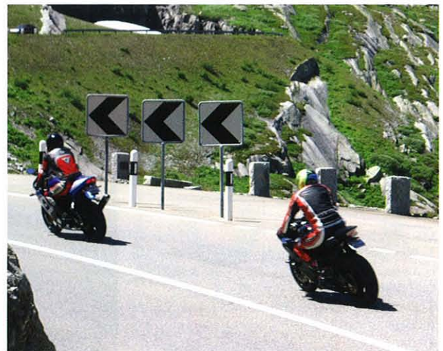
8: Aktive Massnahmen wie Leitpfosten und Leitpfeile sind vor passiven Massnahmen zu prüfen.
