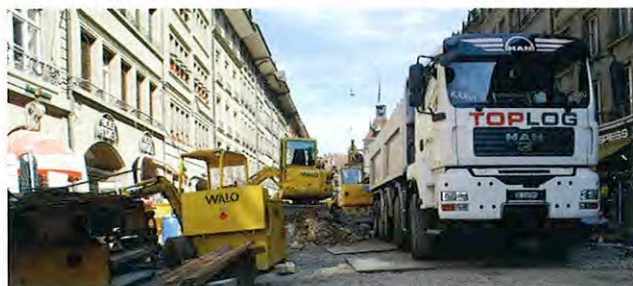
8: Erneuerung Spitalgasse in Bern mit Totalunternehmer.
