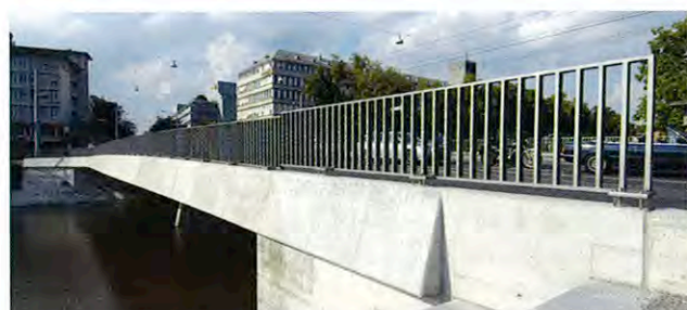
10: Gessnerbrücke Stadt Zürich, gebaut mit Totalunternehmer.
