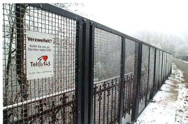
11: Gitterwand zur Suizidprävention.
