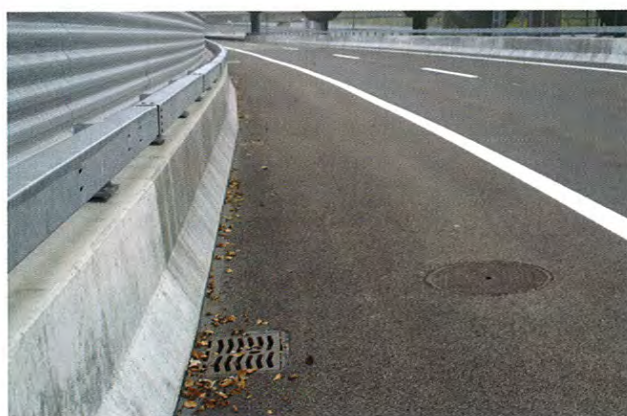
10: Lärmschutzwand auf Leitmauer.
