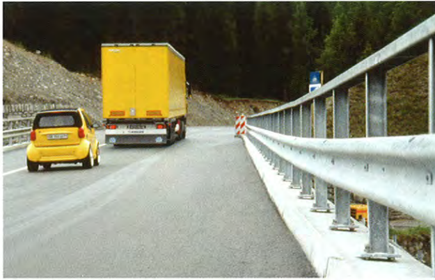
5: Leitschranken mit Profil A und Handlauf (LS A-60140 1,33 m).
