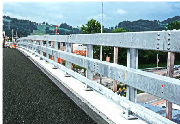
4: Leitschranke mit Kastenprofilen und U-Profil (LS 2×150'180 – 50100 2,00 m).
