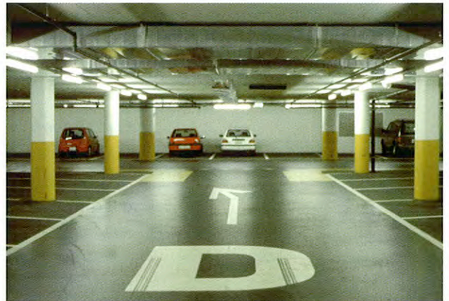
Situation 1: Wände am Aussenrand der Parkfelder und flächige Stützen an den Parkfelderrändern. Die Leuchten sind zwischen den Stützen anzuordnen. Sie beleuchten die Wand und die Fahrbahn. Es kann ein Belag aus Gussasphalt eingebaut werden.
