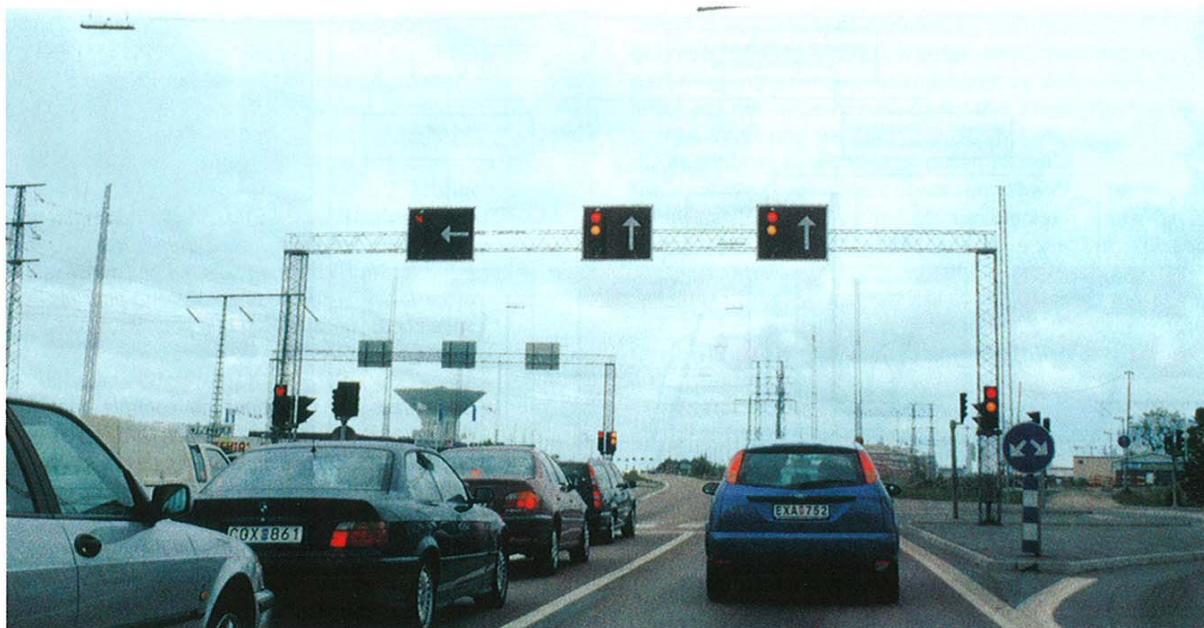
8: Signalportal mit Raumfachwerk.
