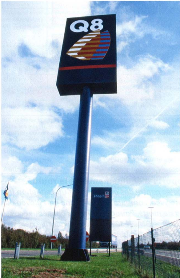
2: Starrer Mast mit Reklametafel am Rand einer Autobahn.
