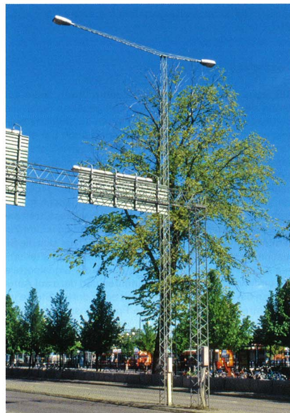
7: Beleuchtungsmast mit Fachwerk.
