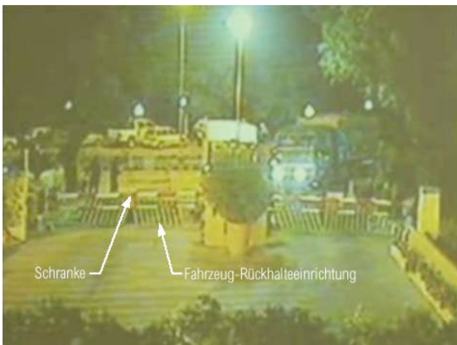
6: Sequenz der CCTV-Aufzeichnung: Sowohl bei der Ein- als auch bei der Ausfahrt sind die geschlossenen Schranke und die ausgefahrene Fahrzeug-Rückhalteinrichtung zu erkennen. [www.youtube.com]
