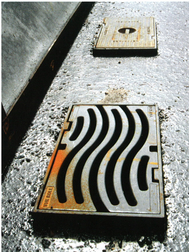
5: Ablauf und Reinigungsschacht am Brückenrand.
