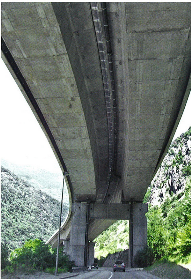
8: Untersicht einer Zwillingsbrücke mit Sammelleitungen.
