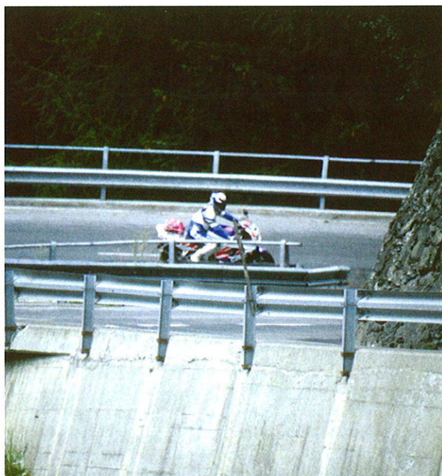
8: Leitschranken ohne Schutzmassnahmen sind für Motorradfahrer eine relevante Gefährdung.
