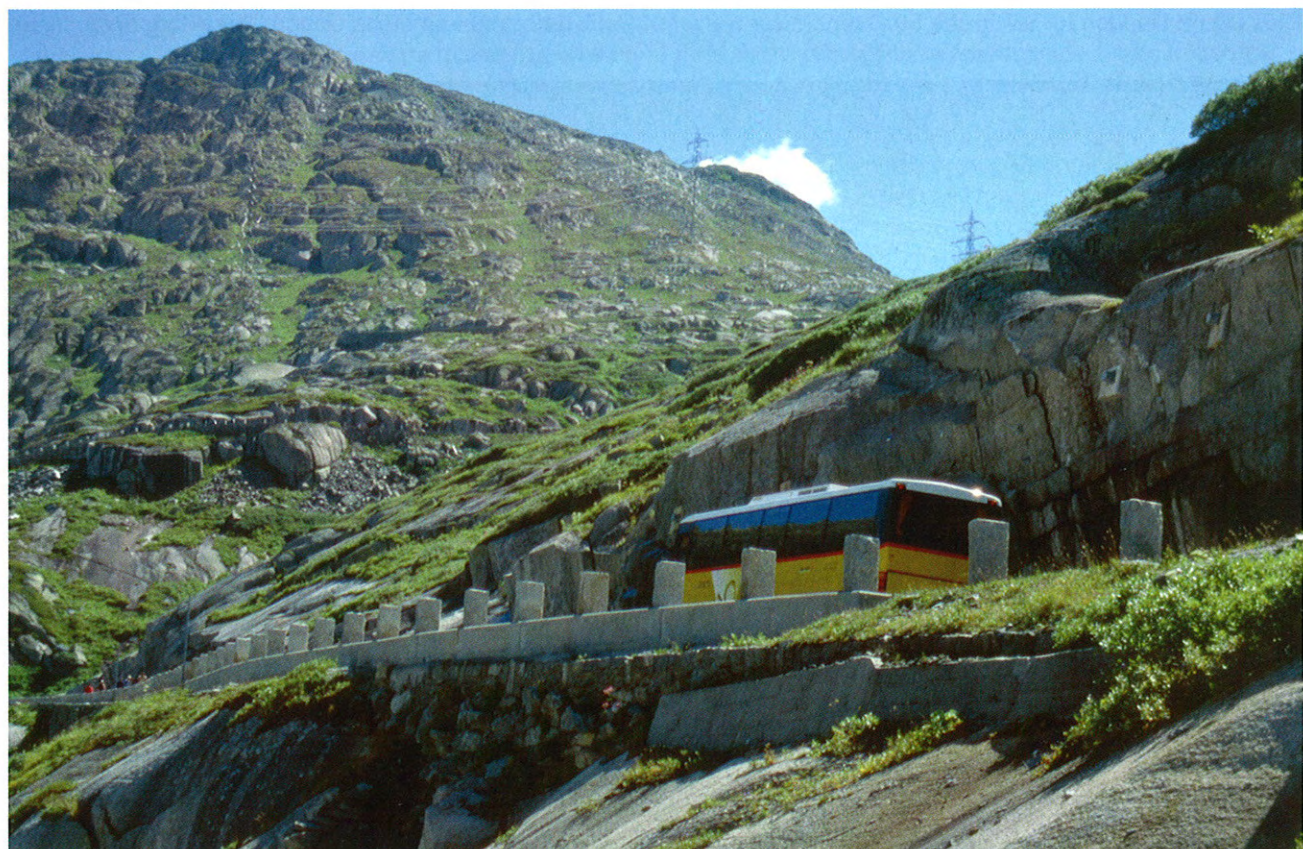
4: Wehrsteine sind Massnahmen der passiven Sicherheit, mit denen sich oftmals auch die Anforderungen des Landschaftsschutzes erfüllen lassen.
