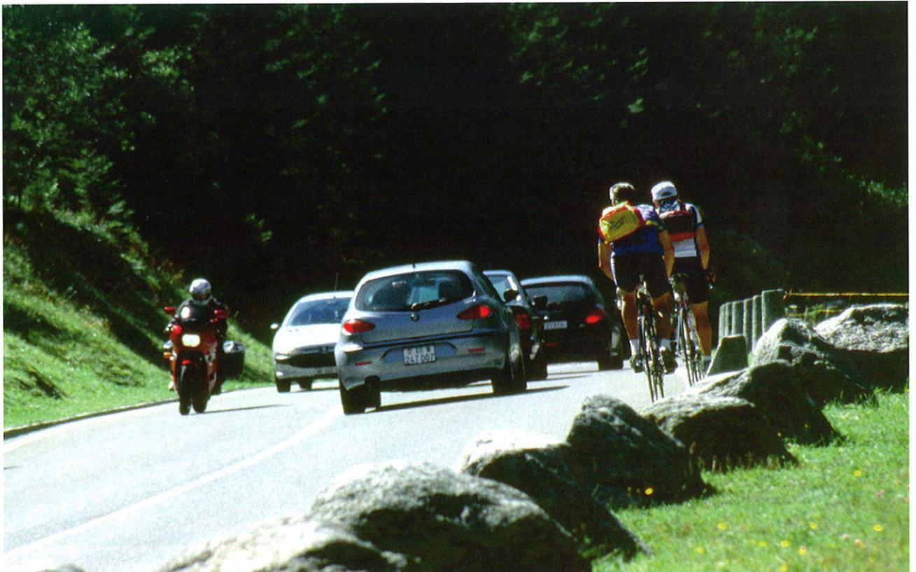
6: Hindernisse am Strassenrand stellen vor allem für Zweiradfahrer eine Gefährdung dar.
