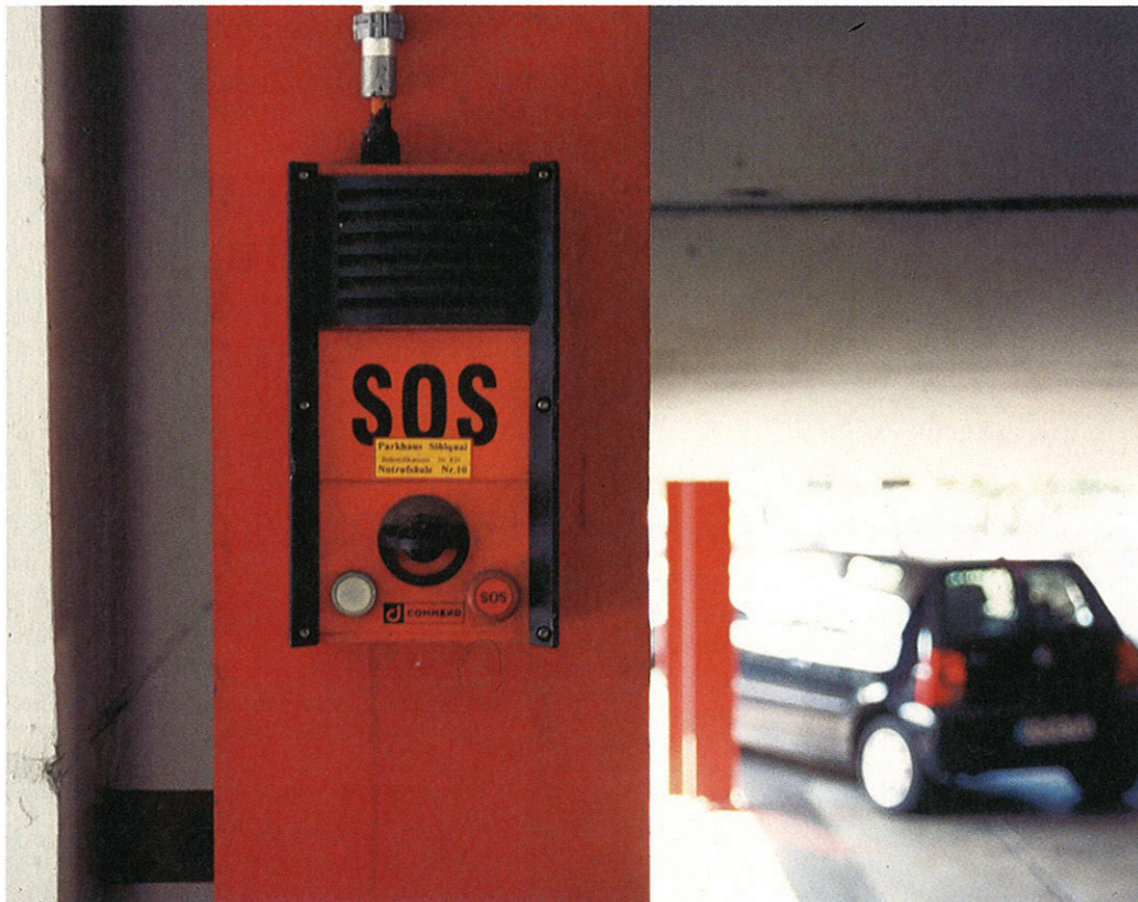
Die Notruftasten müssen gut sichtbar montiert werden. (Bilder: zvg)
