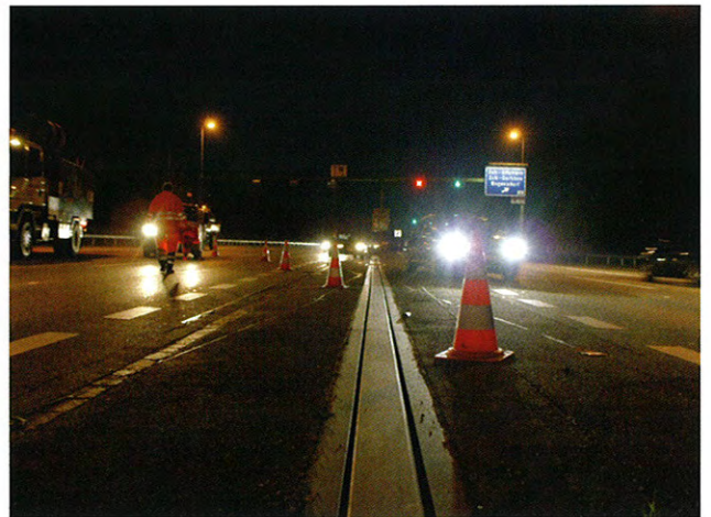
9: Motorisch absenkbarer Schutzeinrichtung im abgesenkten Zustand.
