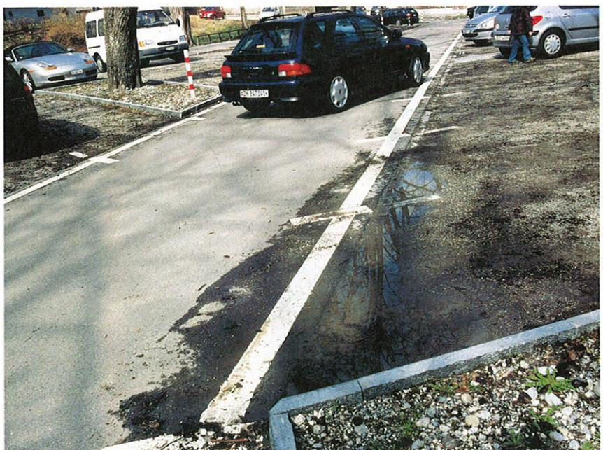
**Übergänge unterschiedlicher Beläge sowie Randabschlüsse erschweren den Unterhalt von Parkplätzen.**
