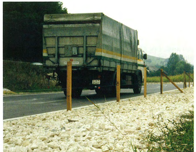
9: Hindernisfreier Seitenstreifen in einer Gewässerschutzzone.
