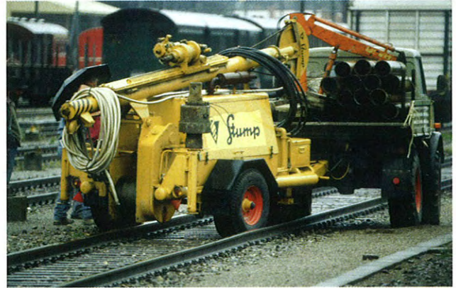
4: Einsatz einer Bohrausrüstung unmittelbar nach der Freisetzung zur Feststellung eines schwebenden Grundwasserleiters in einem kiesig-sandigen Untergrund.
