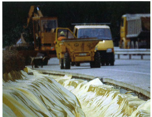
10: Böschungsabdichtung mit Anschluss an den Belagsrand.
