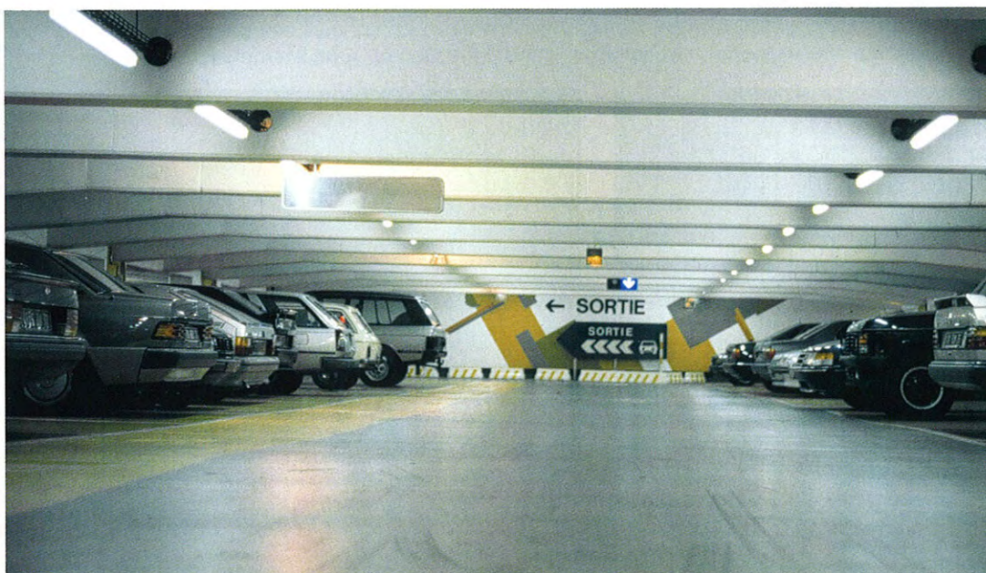
5: Dieses Parkdeck ist sehr transparent, da im Bereich der Parkfelder keine Stützen gebaut wurden.
