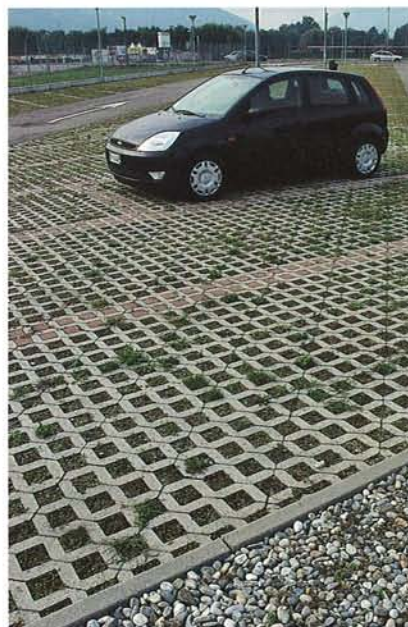
Abb. 2 Oberbau Rasengitterelemente.
