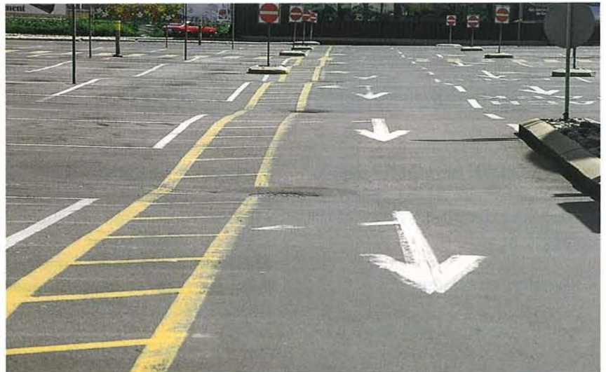
Abb. 4 Entwässerung in punktförmigen Ablauf.
