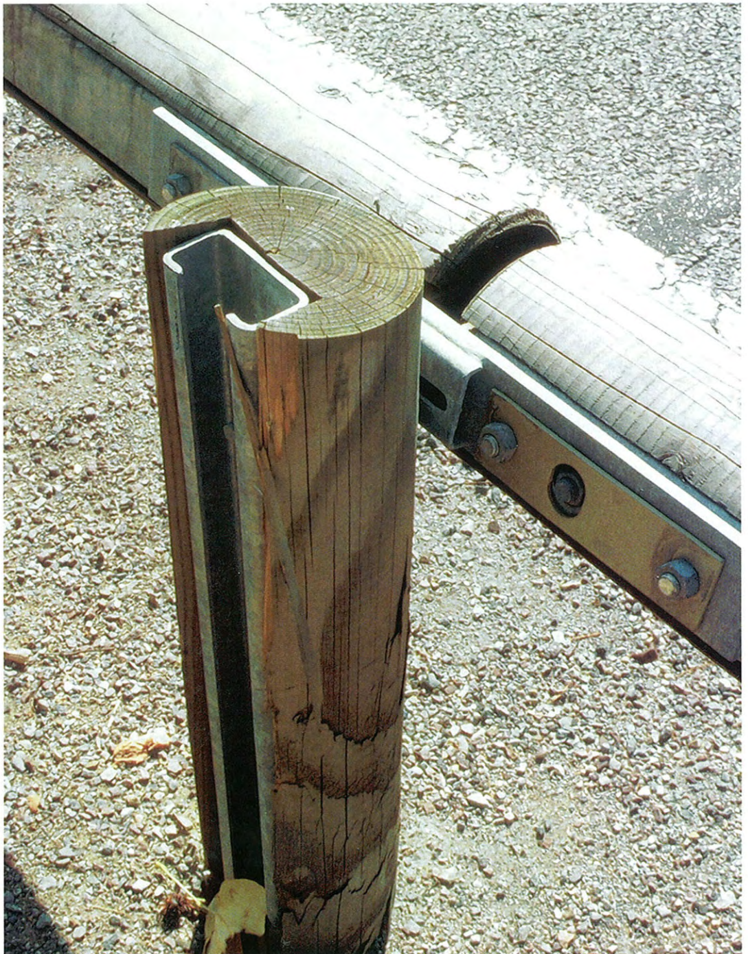
Bild 3: System ähnlich wie Leitschranke auf dem Bild 1, jedoch Pfosten aus C-Profilen mit Holzverkleidung, Aufnahme in Frankreich.
