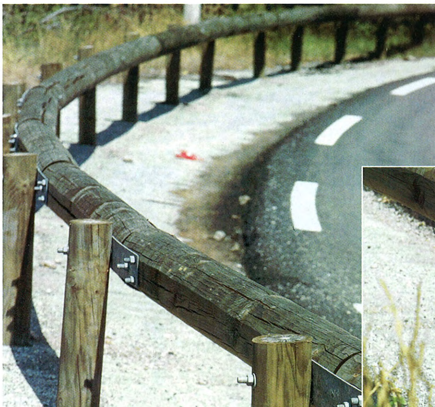
Bild 1: Leitschranke aus Rundholz mit Verbindungselementen aus Stahlblech im Querschnitt der Längselemente, Aufnahme in Frankreich.
