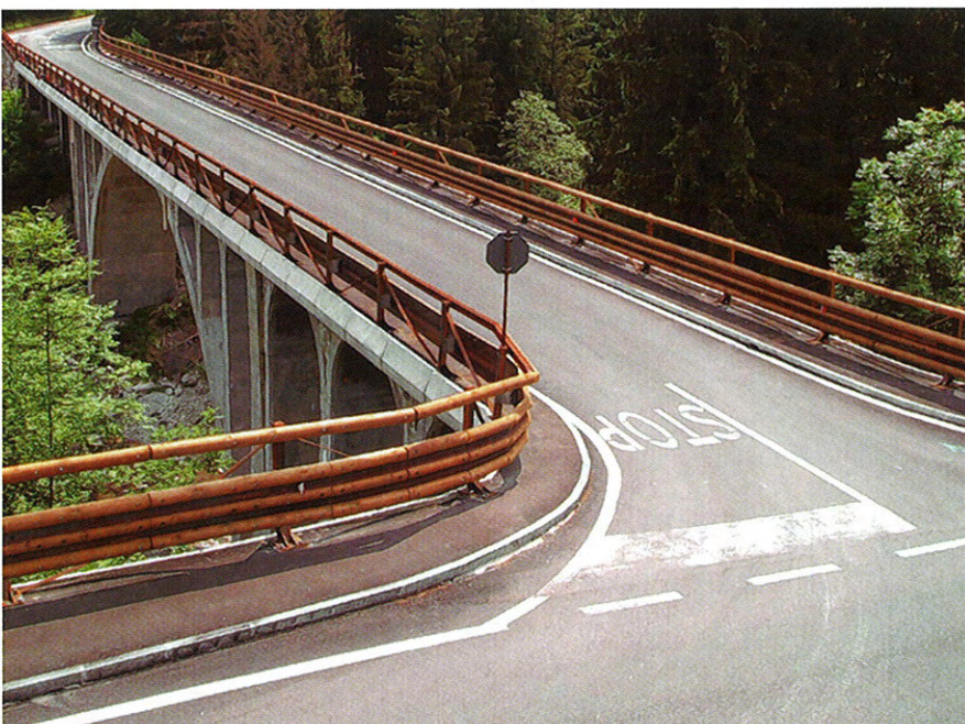
Bild 7: Brückenleitschranke aus Stahl mit U-Profilen und Holzverkleidungen aus halben Rundhölzern.
