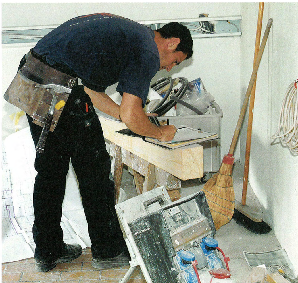
Arbeitsrapporte und Kostenkontrolle bringen es an den Tag: Um sich vor unliebsamen Nachforderungen zu wappnen, lohnt es sich, ein Leistungsverzeichnis sehr sorgfältig abzufassen. (Foto: bs)
