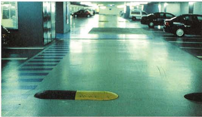
Eine «Welle» bei der Ein- bzw. der Ausfahrt wird bei einem geringen finanziellen Aufwand mit drei Punkten belohnt.
