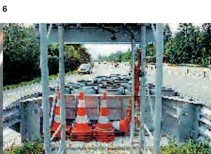
6: Amortisseur de choc avec un anneau d'absorption.
