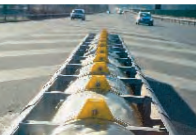
8: Amortisseur de choc avec des éléments remplis d'air.
