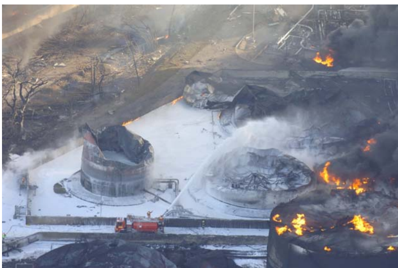
Löschfahrzeug mit Schaumwerfer auf dem Weg zwischen den Tanks 915 und 912 (im Vordergrund) und 916 und 913 (v.l.n.r.). Bis auf einen kleinen Brandherd auf dem Dach des Tanks 912 sind die Tanks ausgebrannt. Der Schaumteppich auf dem Boden verhindert den Ausbruch von Bränden weitgehend. Interessant sind jedoch die kleinen Brandherde entlang der Wand der Auffangwanne
