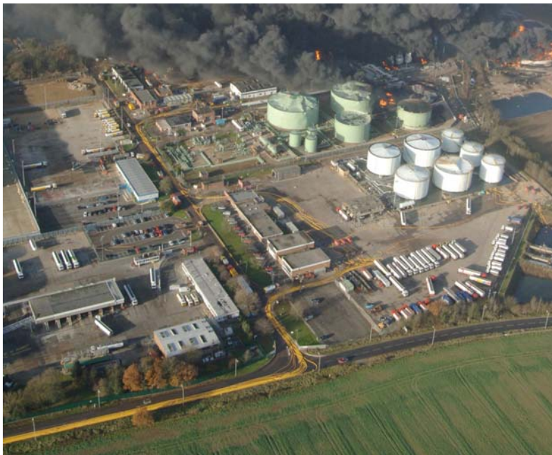
Schlauchleitungen beim Eingang zum Gelände des Tanklagers der HOSL auf der Ostseite der Anlage und Verlegung der Schläuche innerhalb des Areals
