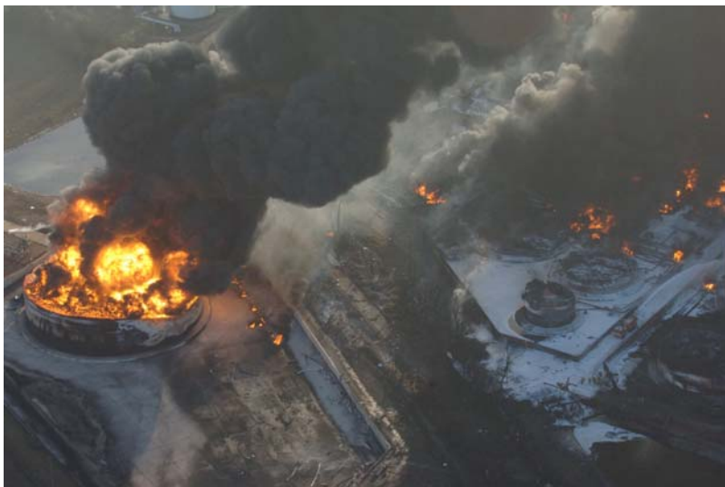
Situation am Montag, 12. Dezember: Der grosse Tank 12 (links) ist im Vollbrand, wird aber nicht gelöscht. Rechts sind die ausgebrannten Tanks 913, 914, 915 (ganz rechts am Bildrand) und 916 zu erkennen. Im Schaumteppich neben den Tanks sind noch an zahlreichen Stellen kleinere Brände zu sehen.
