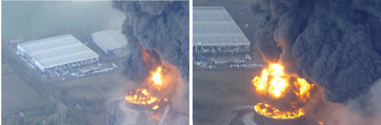
Halle (5) links und Halle (6) rechts sowie brennender Tank 12 im Vordergrund
