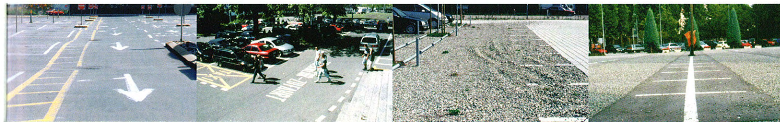
9: Profilage du parc avec évacuation des eaux par des avaloirs.
