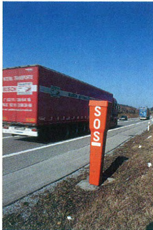
10: Umfahrbare Notrufsäule ohne Schutzeinrichtung.
