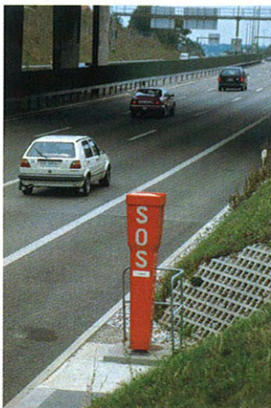
12: Ungünstige Nische bei Notrufsäule.
