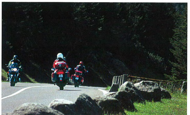
7: Felsblöcke im Seitenstreifen.
