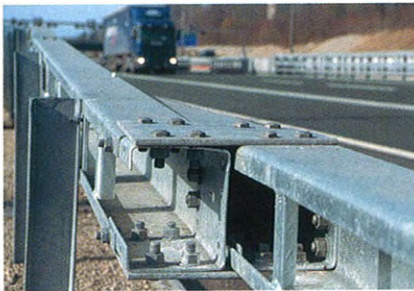
10: Einfache Verbindung von Kastenprofilen mit Verankerungsplatten.
