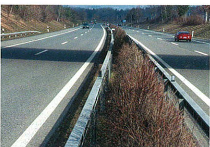
8: Mittelstreifen mit zwei hintereinander geführten Leitschranken mit Kastenprofilen 150/180 mm.
