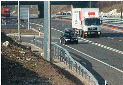
6: Objektschutz mit Leitschranke mit zwei Kastenprofilen 150/180 mm.
