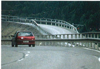
5: Leitschranke mit Planke Profil A und Handlauf in gebirgigen Regionen.
