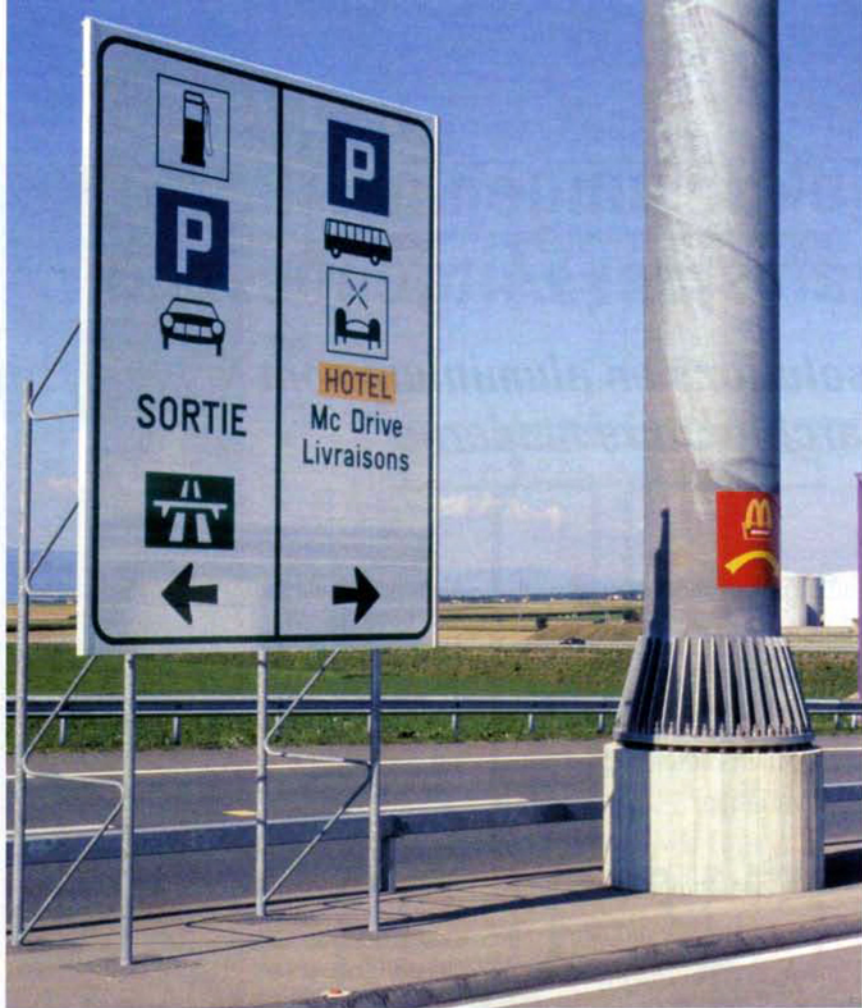
Links ein umfahrbares, rechts ein starres Tragwerk
