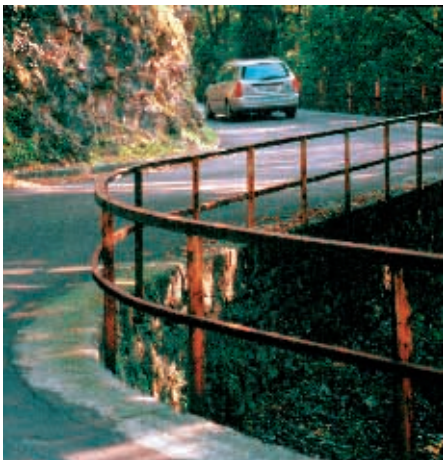
7: Route de montagne avec un garde-corps simple en profilés d'acier.
