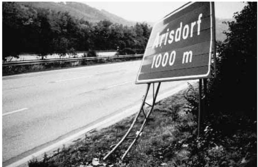
1: Erstes Signal in der Schweiz mit Fachwerkständer, mit Schäden nach einem Anprall eines PW mit geringer Geschwindigkeit.
