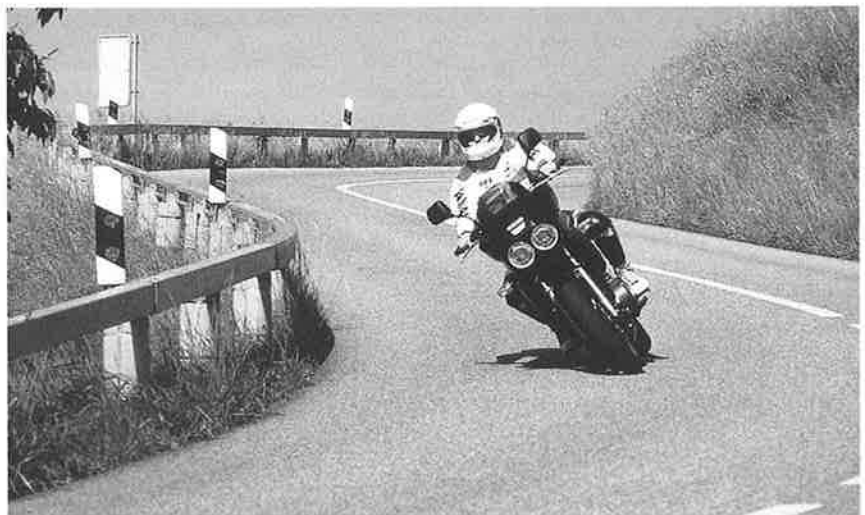
1: Sicherheitsmassnahmen an Leitschranken zum Schutz der Motorradfahrer.
