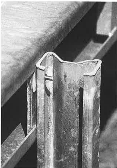
2: Leitschrankenpfosten mit Sigma-Profil (S-Profil).
